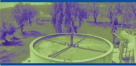
Los lechos de baja carga tienen el problema de que tienden a atascarse, debido a la proliferación de la zooglea, por ello a pesar de su buen rendimiento 90%, se usan poco y la tendencia es a utilizar filtros en alta carga con recirculación. En algunos casos se utilizan filtros en alta carga y en baja carga, simultaneando su funcionamiento.
