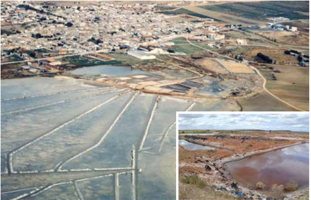
Figura 102. Motas para la extracción de sal y balsas construidas para la retención de vertidos en la laguna hipersalina de Quero (Toledo). Año 2009 (fotografía: © SAF J.I. Rozas).
