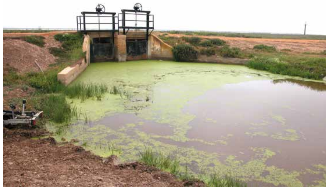
Figura 158. Una de las compuertas situada en la denominada Montaña del Río, en la zona de Casa Brenes, que controla la inundación de la marisma de Doñana y la separa del río Guadalquivir. Año 2006.
