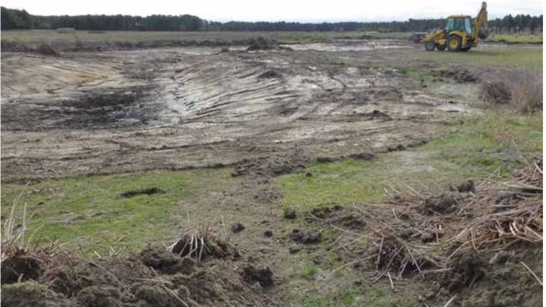
Figura 143. Laguna Navacornales (Cantalejo, Segovia), decapado y retirada de arena. Año 2017.
